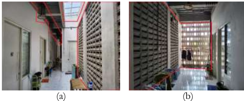
Gambar 4. Atap polikarbonat di lantai 3 (a) dan fasad pasangan bata (b)
