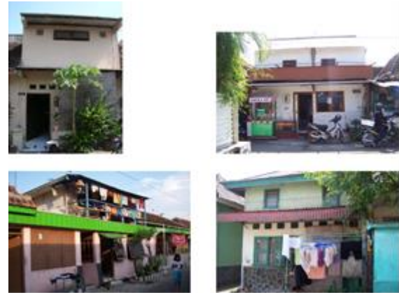
Gambar 5. Fasad Bangunan Semi Vertikal (sumber: dokumentasi 2007)
