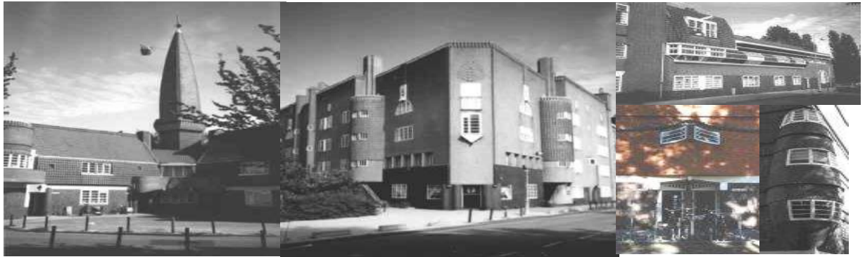
Penggunaan tower-tower pada bangunan
