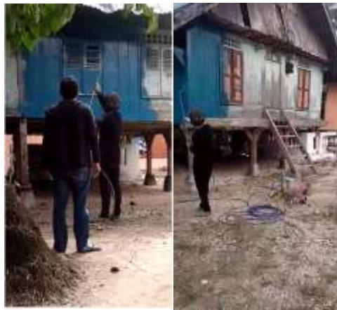
Gambar 7. Proses pengecatan rumah ( Sumber: Dokumentasi dan Analisis, 2020 )
