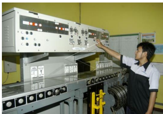
Gambar 6. Sistem Persinyalan Elektrik Tokenless Block Intrument di Stasiun Banyuwangi (Sumber : IRPS SB 2020)
