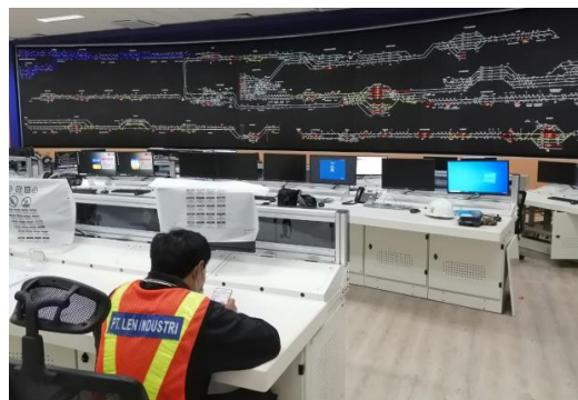
Gambar 7. Pusat Pengendalian Operasi KA Stasiun Manggarai dengan Sistem Digital (Sumber :PT LEN Industri)
