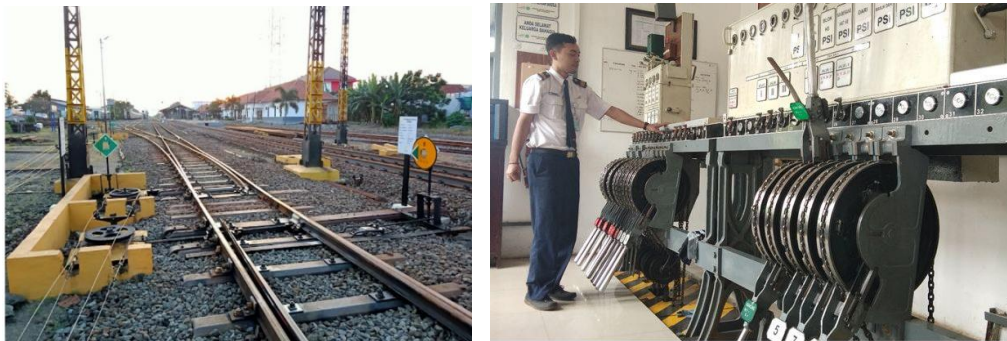
Gambar 5. Sistem Wesel Mekanik dan Persinyalan di Stasiun (Sumber : IRPS SM 2019)
