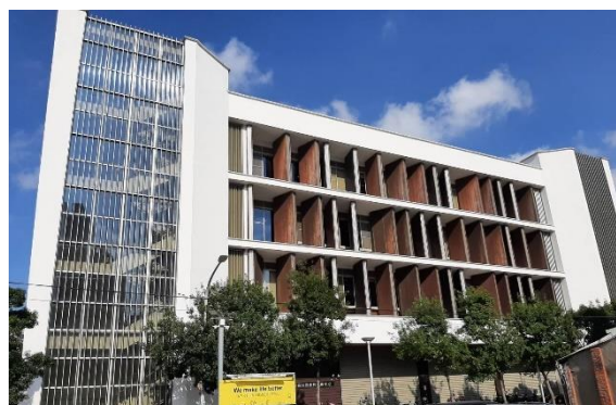
Gambar 2. Fasad Depan Bangunan (sumber: Penulis, 2022)
