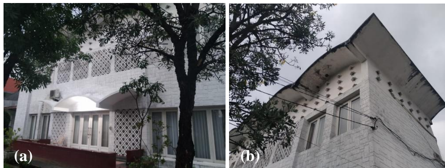
Gambar 7. (a) Roster pada Dinding; (B) Lubang-Lubang Angin pada Dinding Atas (Sumber: Dokumentasi Pribadi, 2022)
