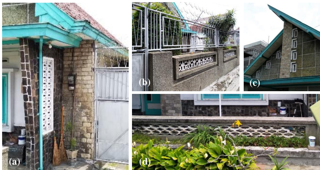
Gambar 6. (a) Roster pada Dinding; (b) Roster pada Pagar; (c) Lubang-Lubang Angin pada Dinding Atas; (d) Roster pada Baduk (Sumber: Dokumentasi Pribadi, 2022)
