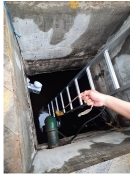
Gambar 8. Pengukuran Atmosfer Dalam Groundtank
