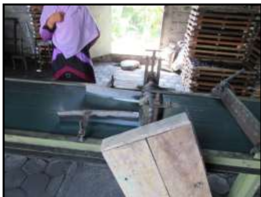
Gambar 2. Belt conveyor yang telah terpasang
