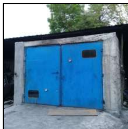
Gambar 3. Oven permanen yang telah jadi
