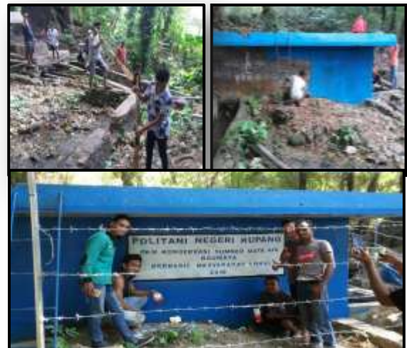
Gambar 10. Pembersihan, Pengecatan dan Pemagaran Bak Penampung.
