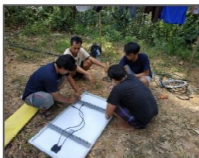
Gambar 5. Pemasangan Panel Surya
