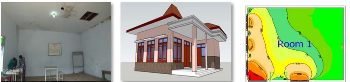
Gambar 8. Kondisi pencahayaan buatan pada bangunan eksisting rumah baca
