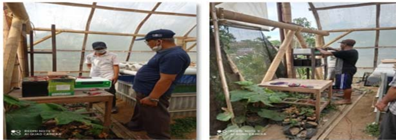
Gambar 7. Pemasangan power bank pada PLTS
