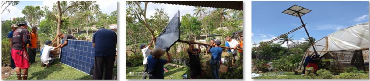
Gambar 6. Aktivitas pemasangan bracket -panel surya
