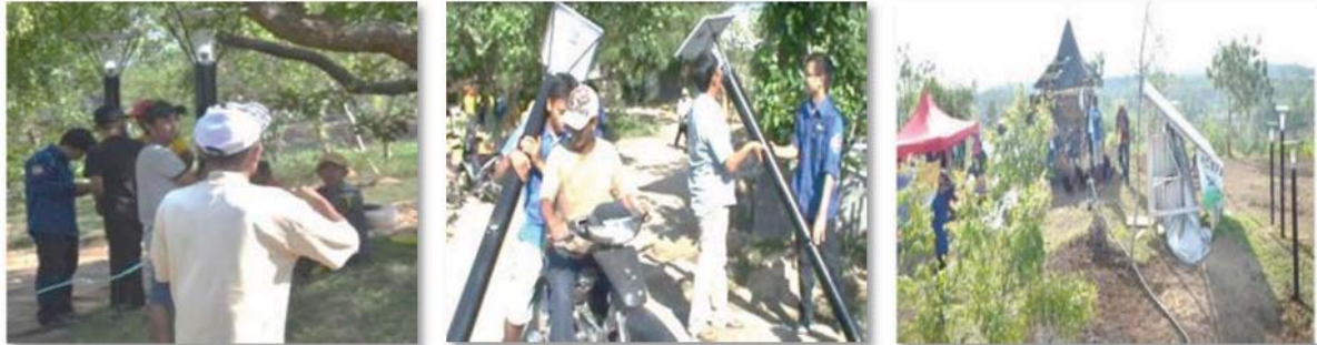
Gambar 6. Hasil pengujian lampu taman, pengangkutan lampu taman menuju ke bukit Curah Cottok dan pemasangan lampu taman
