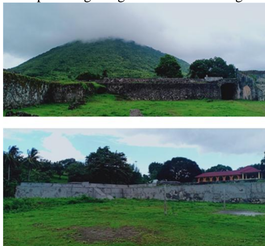
Gambar 5. Dua sisi berbeda dari benteng Nassau. Tidak/belum dipugar (atas), sisi lain yang sudah dipugar (bawah). Sumber: Dokumentasi penulis, 2019
