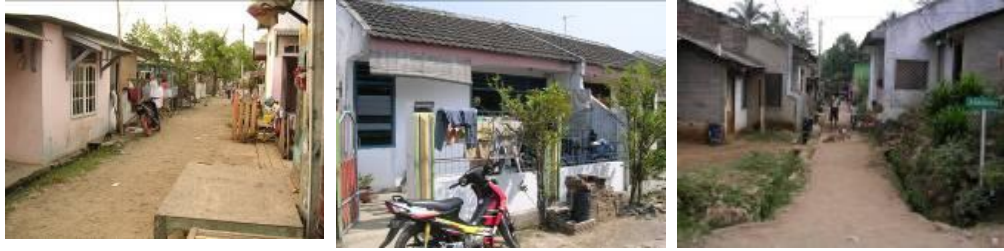
Gambar 9 : Intervensi ruang publik pada perumahan MBR (Dok.Penulis)
