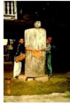
Gambar 4 : Tiang dan pondasi umpak Sumber : Siswanto, Ari, 1999 b
