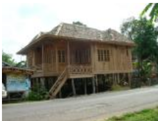
Gambar 7 : Rumah Knock-down Tanjung Batu
