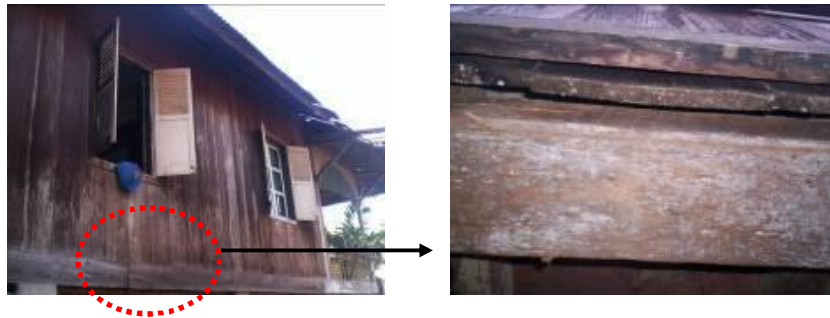
Gambar 4. Sistem sambungan kayu dengan dijepit
