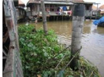
Gambar 15: Memperlihatkan kondisi rumah rakit yang diikat pada tiang.(survai 2008)
