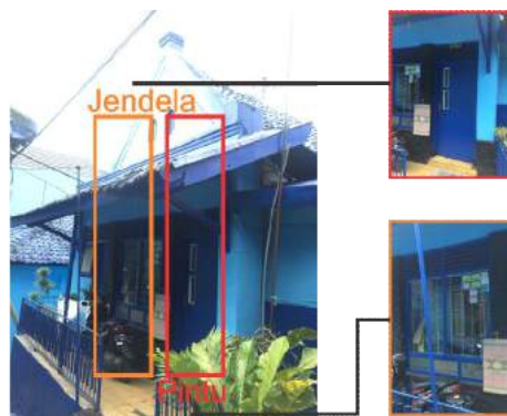
Gambar 7. Varian 1 elemen satu daun pintu yang terletak di samping fasad bangunan (Sumber: Dokumentasi pribadi, 2018)
