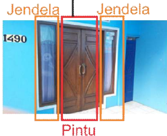
Gambar 14. Varian 2 elemen dua daun pintu yang terletak di samping fasad bangunan
