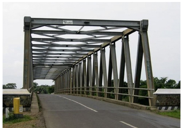
Gambar 3: Jembatan baja (Sumber: internet, 2016)
