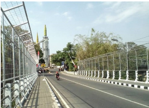
Gambar11: Hasil dari peninggian pagar di jembatan Gandong 1 (Sumber: internet, 2016)
