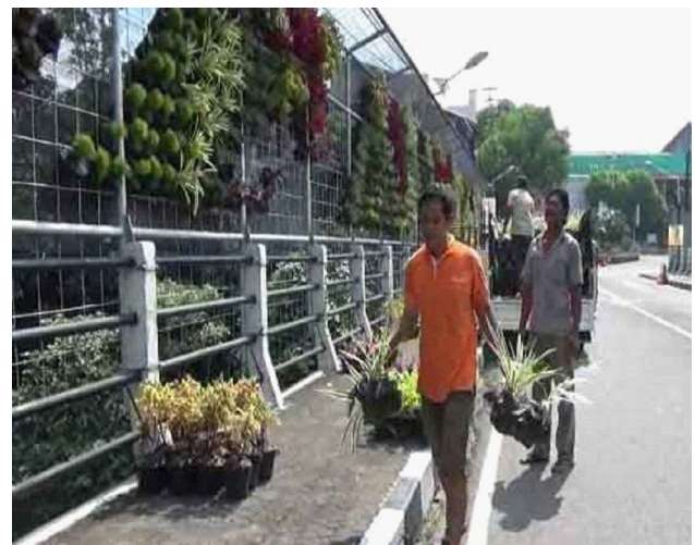
Gambar12: Proses pembuatan vertical garden di jembatan Gandong 1 (Sumber: internet, 2016)
