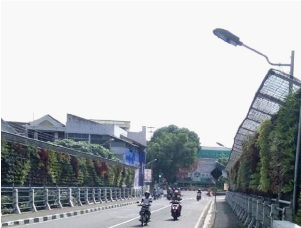
Gambar13: Hasil dari pembuatan vertical garden di jembatan Gandong 1 (Sumber: internet, 2016)
